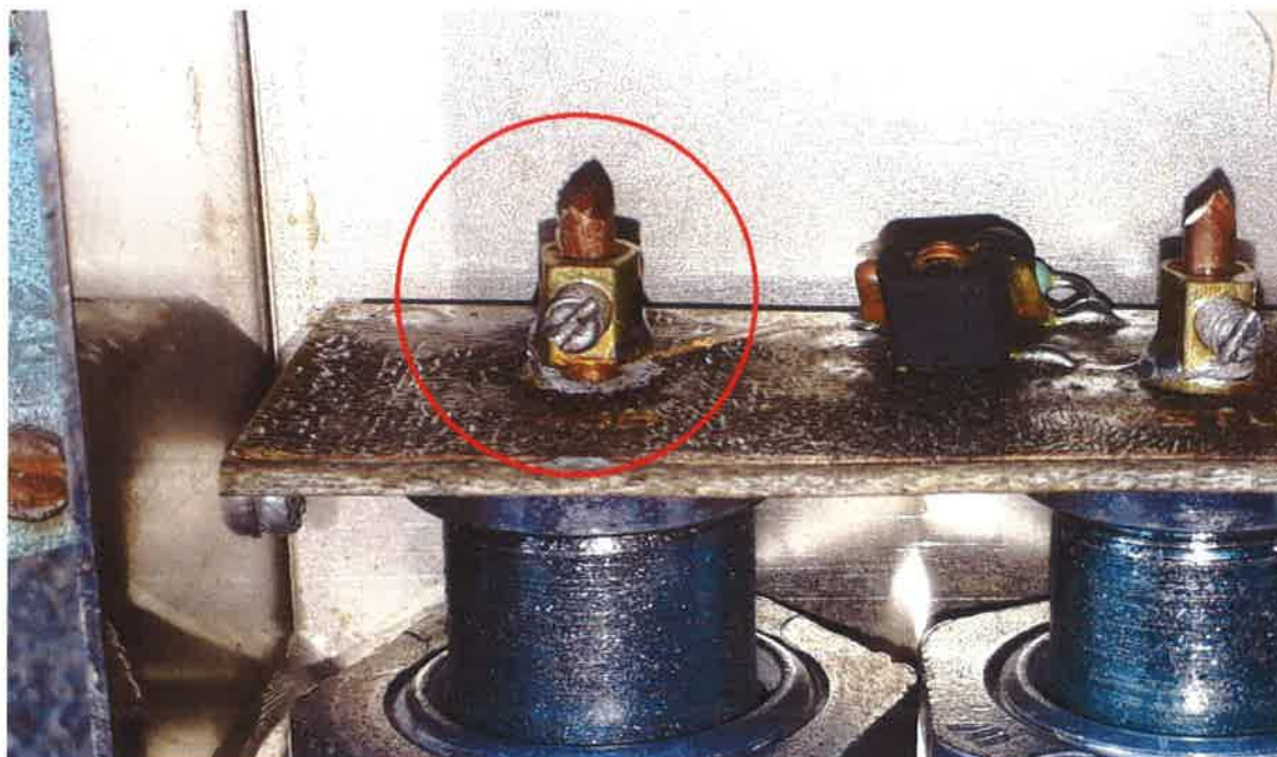
Obrázek 2: Příklad utržení svorkovnice v rozvaděči K181.
