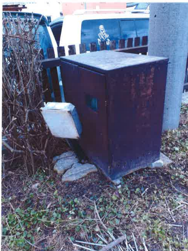
Obrázek 1: Příklad umístění rozvaděče.
